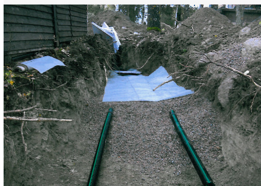
Exempel på bilder från anläggandet av ett avlopp
