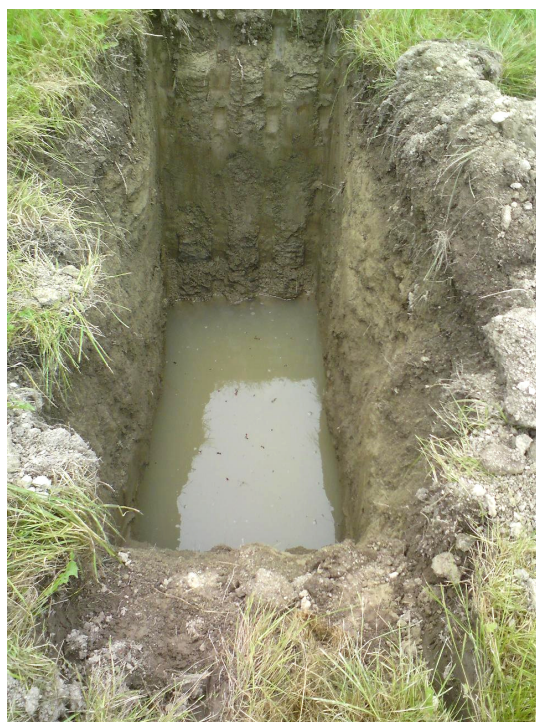
Provgrop med högt grundvatten
